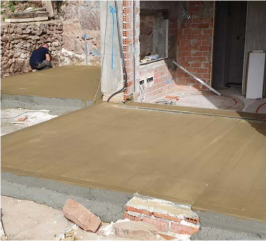
Porche entrada vivienda en construcción
